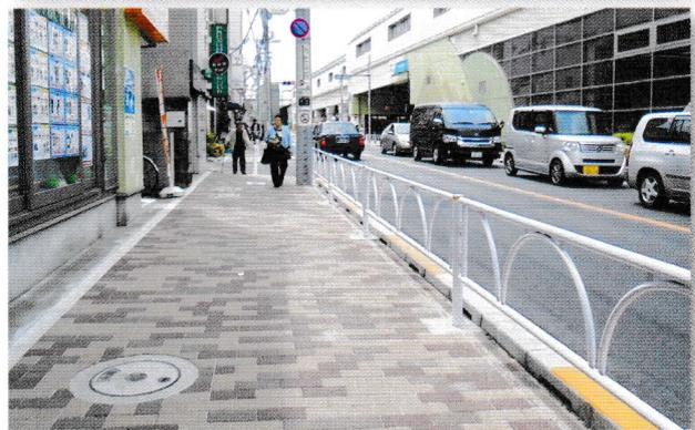
▲電柱位置や段差の解消、インターロッキングによる整備済み
