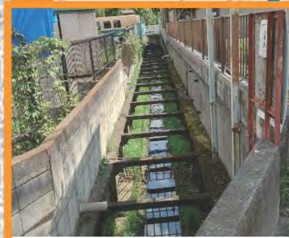
I. 谷沢川開渠区間 (桜丘3-28付近)
